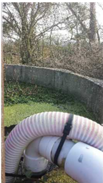
Tuyau souple du relèvement
