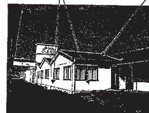
Vue SUD-EST Bureaux 1,2 et 3
